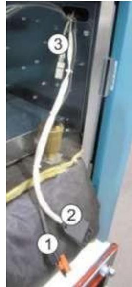
Zur elektrischen Verbindung der beiden Kesselhälften befinden sich am linken Kesselteil (Holz) drei Steckdosen, am rechten Kesselteil die dazugehörigen Stecker. Diese sind miteinander zu verbinden. Ein Vertauschen ist durch die Kodierung nicht möglich.
